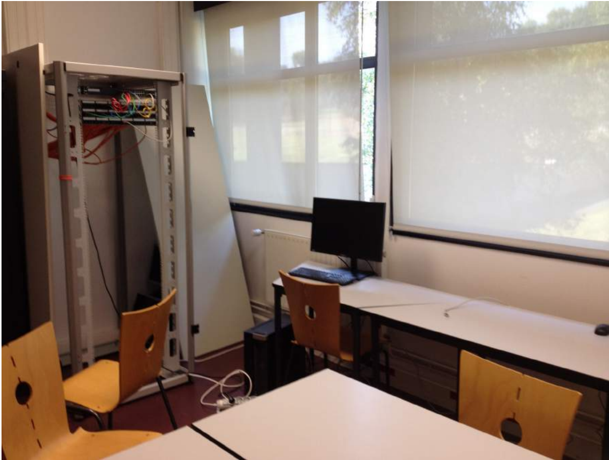
Illustration 38 : Intérieur de la salle PROMETEE. Stores occultant aux fenêtres
