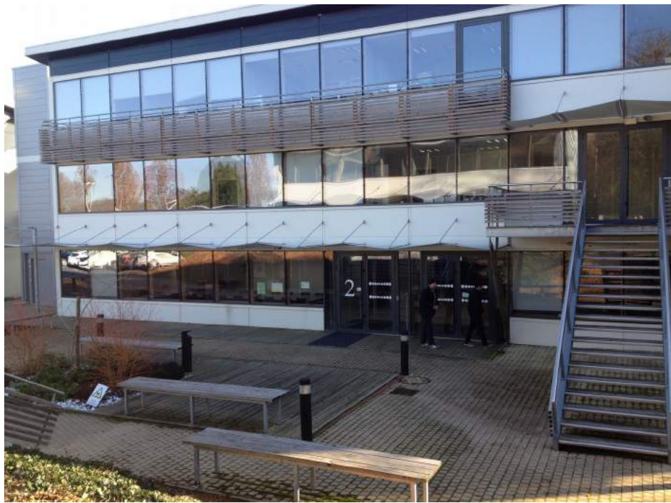
Illustration 13 : Bâtiment principal du pôle Élosys
